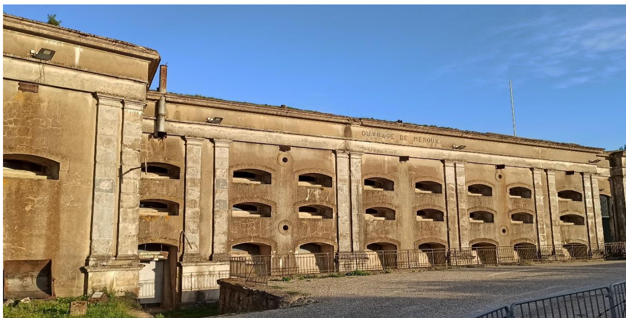
L'ouvrage de Meroux-
